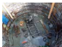
トンネル先進ボーリング
