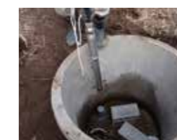
井戸掘削工事
