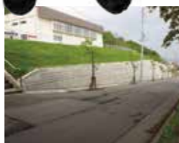
高盛土擁壁の改築
