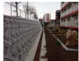
谷地盛土上の擁壁改修
