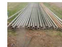
井戸メンテナンス工事
