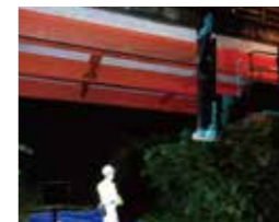
夜間橋梁点検(鉄道上)
